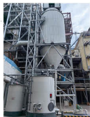
蒸发器及配套水箱完工效果
