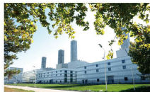
F 级燃气大容量燃气余热深度利用项目厂房
