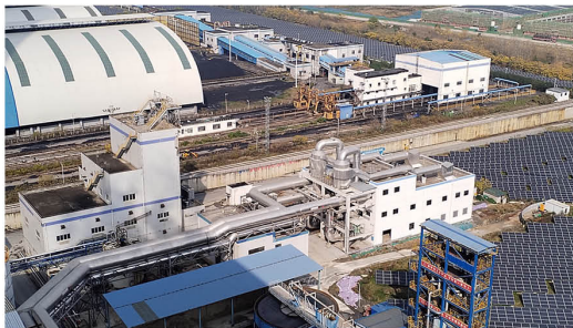
岳阳电厂一体化处理机系统
