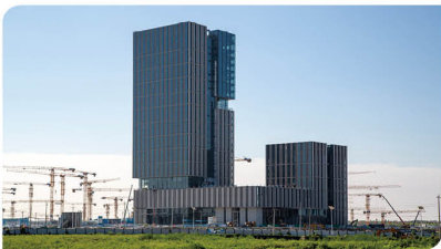
建设中的雄安华能总部办公大楼
