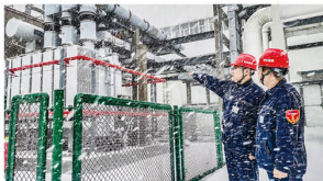
长春热电厂暴雪中开展安全检查
