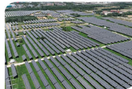
曲沃 300MW 光伏项目
